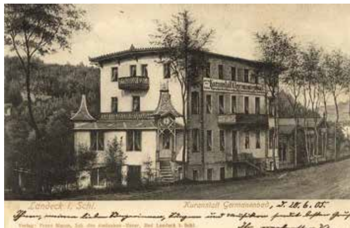
Po pierwszej modernizacji w 1900 r. Pocztówka datowana na 20.6.1905 r.
